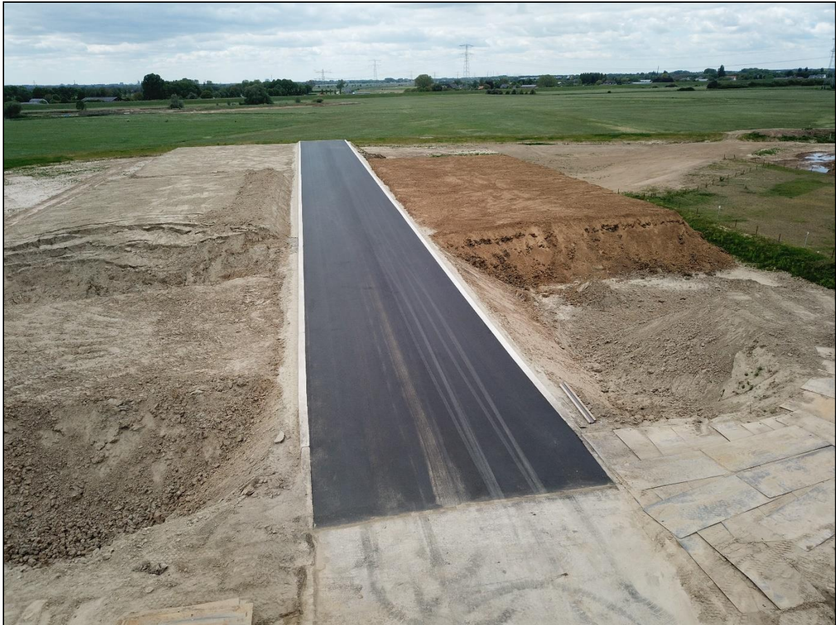
Figuur 16. Asfaltering binnen de uitbreiding van de steenfabriek.
